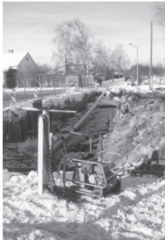
Kanalizācijas un ūdensvada spiedvadu izbūve zem autoceļa Rīga–Jelgava Jaunolainē
